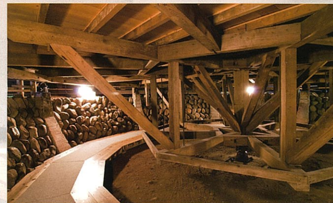
回り舞台 舞台中央の円形に切った部分を奈落(床下)で、ろくろ仕掛けにより人力(4人)で回します。直径9.73メートル
