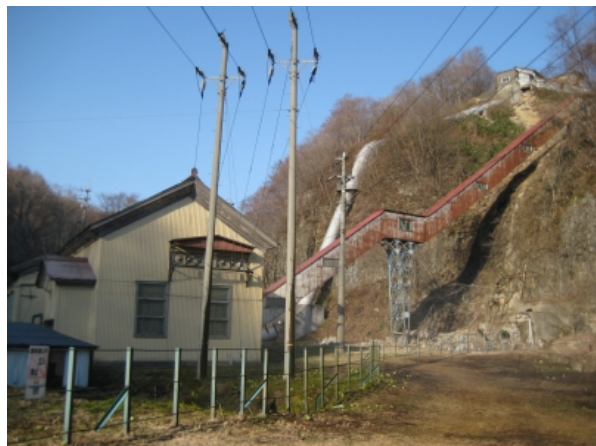
銚子第一発電所
